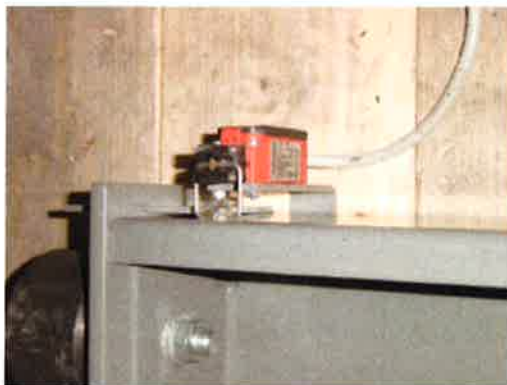
Figur 1-2: Sikkerhetskontakt for bufferstøtte
