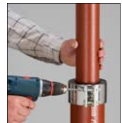
Elektrisk eller hydraulisk verktøy kan benyttes.
