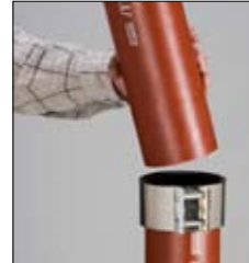
Skyv den andre rørenden/delen inn i gummi mansjetten.
