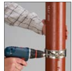
Skru sammen med elektrisk drill eller annet håndverktøy, bits på 6 mm.
