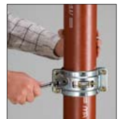
Skru fast de fire boltene vekselvis med en fastnøkkel eller tilsvarende. Pådragsmoment min 20 Nm. Maks 25 Nm.
