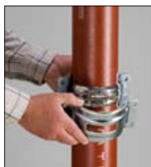
Skru fast de fire boltene vekselvis med en fastnøkkel eller tilsvarende. Pådragsmoment min 20 Nm. Maks 25 Nm.
